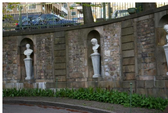
Delar av Piperska muren från 1702
