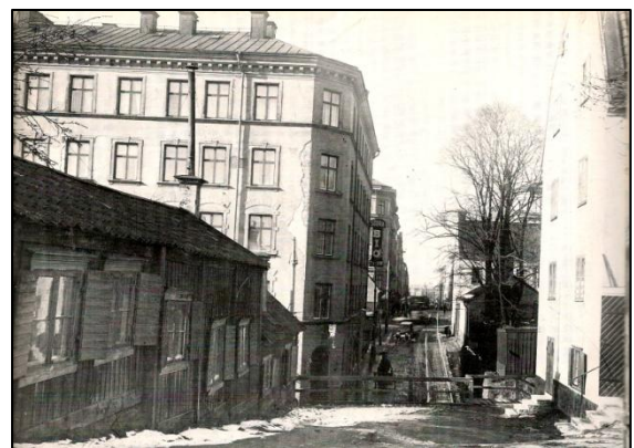
Renstiernas gata innan den sprängdes ner. Huset till höger det Backsénska huset. Stockholms Stadsmuseum.
